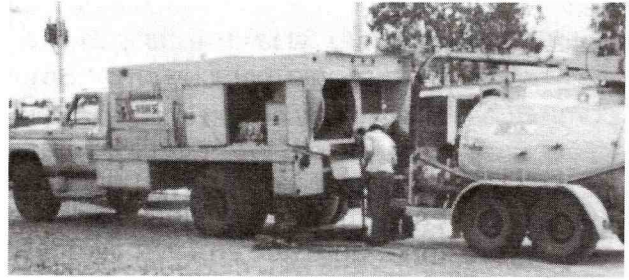
Uno de los primeros camiones hidroneumáticos desazolvando una línea del alcantarillado.
