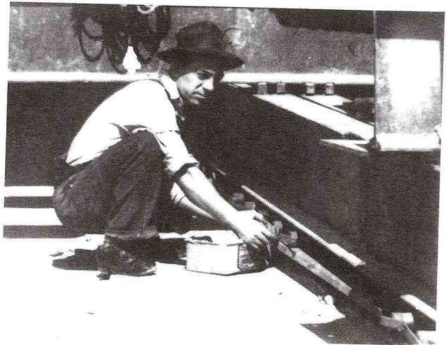
Colocación de los rodillos.
