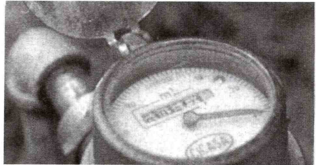
Medidor de agua domiciliario, colocado dentro del programa de introducción.
