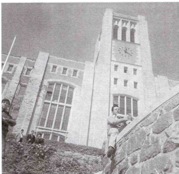
Edificio principal de la Universidad Técnica Federico Santa María en Valparaíso, Chile.
