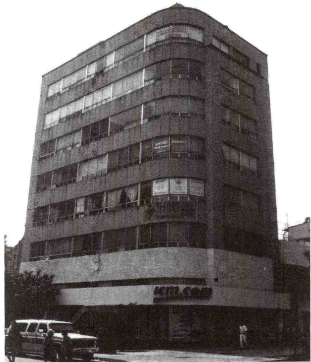
Edificio de siete niveles con estructura de concreto construido en 1945 en Juárez y Pavo.
