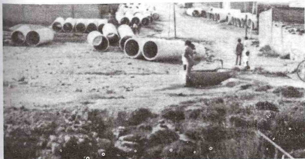
Acueducto poniente IV.
