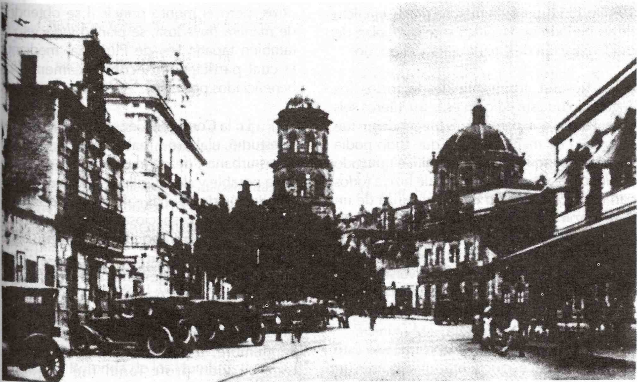
La zona de la antigua estación del ferrocarril.
