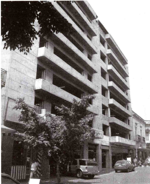
Edificio del estacionamiento Colón, construido con concreto reforzado.
