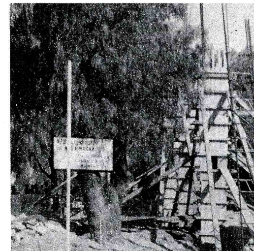
CIMBRADO DE COLUMNAS
